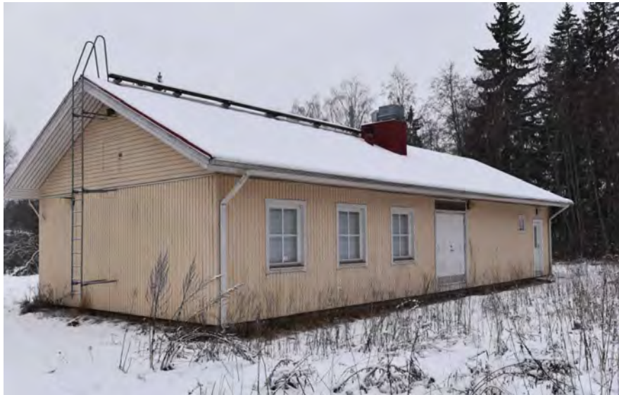
Kuva: Itäpääty ja pohjoissivu.
