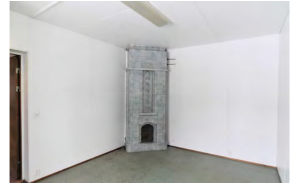
Kuva: Luja-levyllä levytetyt seinät ja katto.
