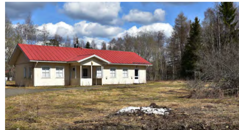
Kuva: Kaupungin toimesta on pihapiiriin rakennettu työpajarakennus.
