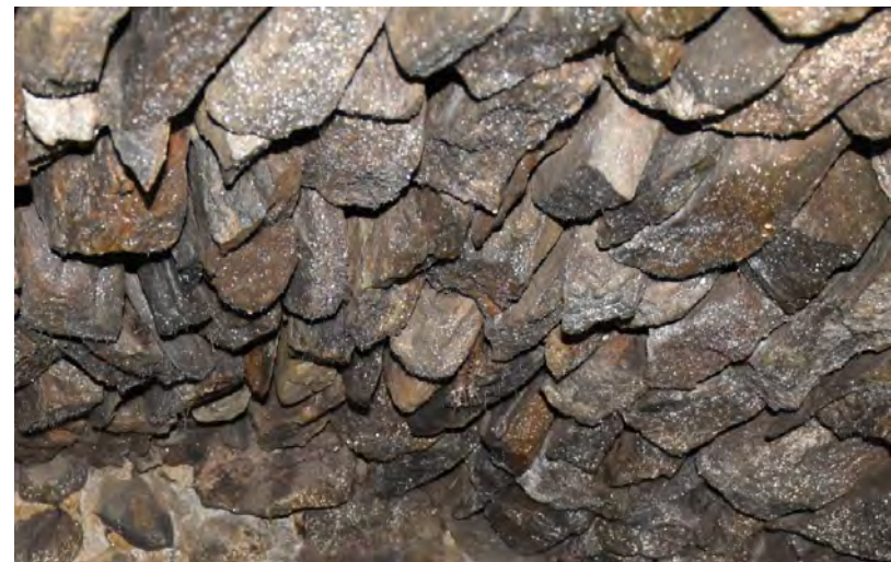
Kuva: Kinnarin kellarin tynnyriholvikatto.
