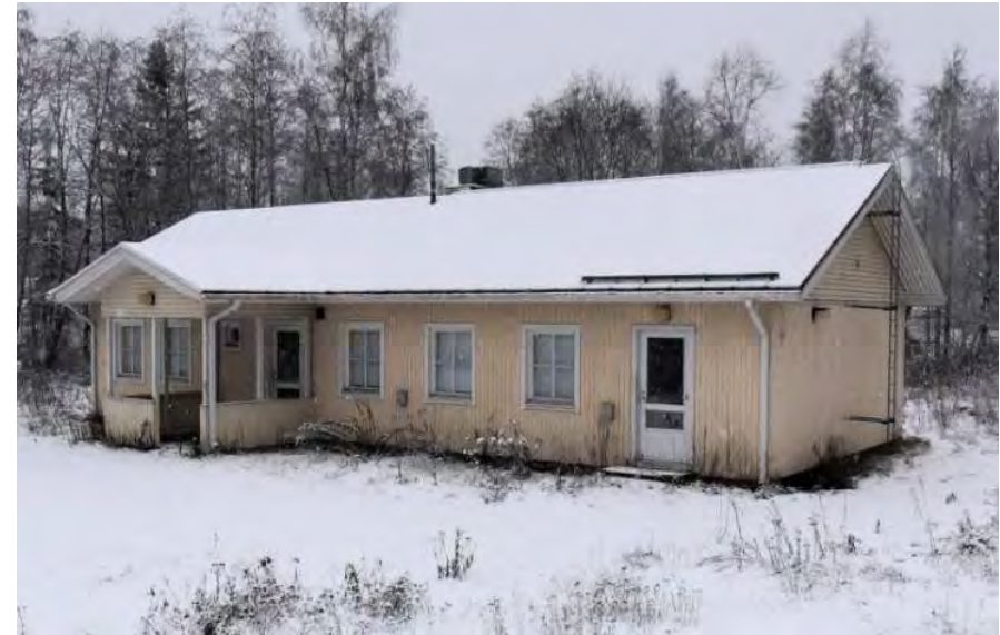
Kuva: Eteläsivu eli pääfasadi ja itäpääty.
