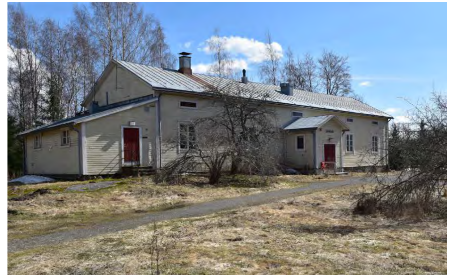
Kuva: Kinnarin päärakennus 2020. Ovet vaihdettu ja kuistin ilme muuttunut.
