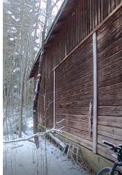
Kuva: Aitan takaseinää.
