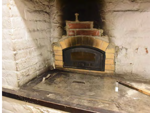
Kuva: Uunin suuaukkoa on korjailtu.
