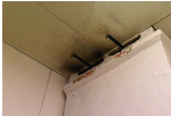
Kuva: Pellit, katto- ja seinäpinnat.
