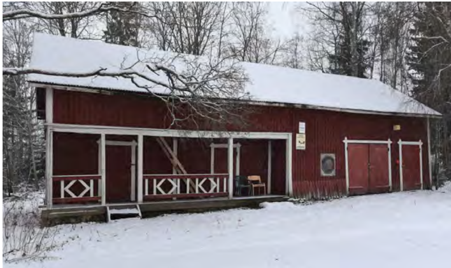
Kuva: Aitta- ja kalustovajarakennus on pihan länsireunalla. Ovet ja vuorilaudat on kunnostettu. Vuonna 2000 laadittua suunnitelmaa jätekatoksen rakentamisesta kalustovajaan ei toteutettu.
