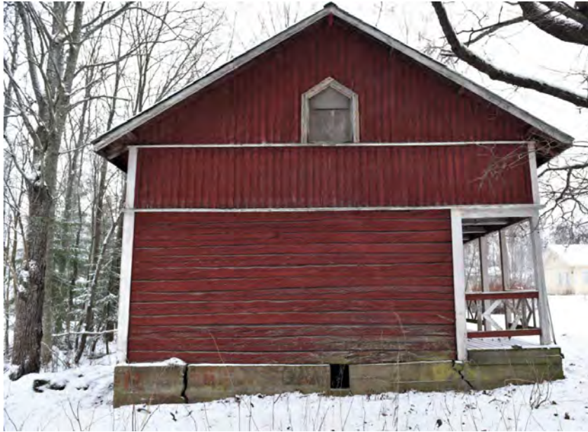
Kuva: Aitan eteläpään hirsiseinää ja pystyauoitettu ullakko.
