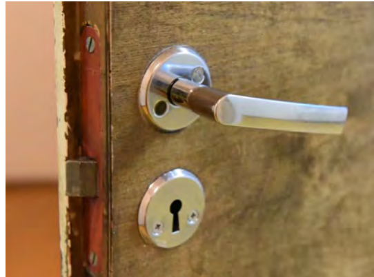
Kuva: Laakaoven painike ja avainkilpi.
