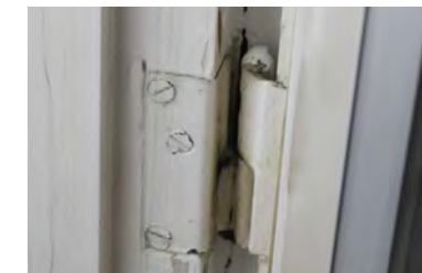
Kuva: Huullettu nostosarana.
