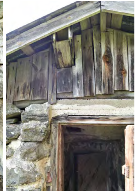
Kuva: Eteistilan laudoista tehty poistoilmahormi.
