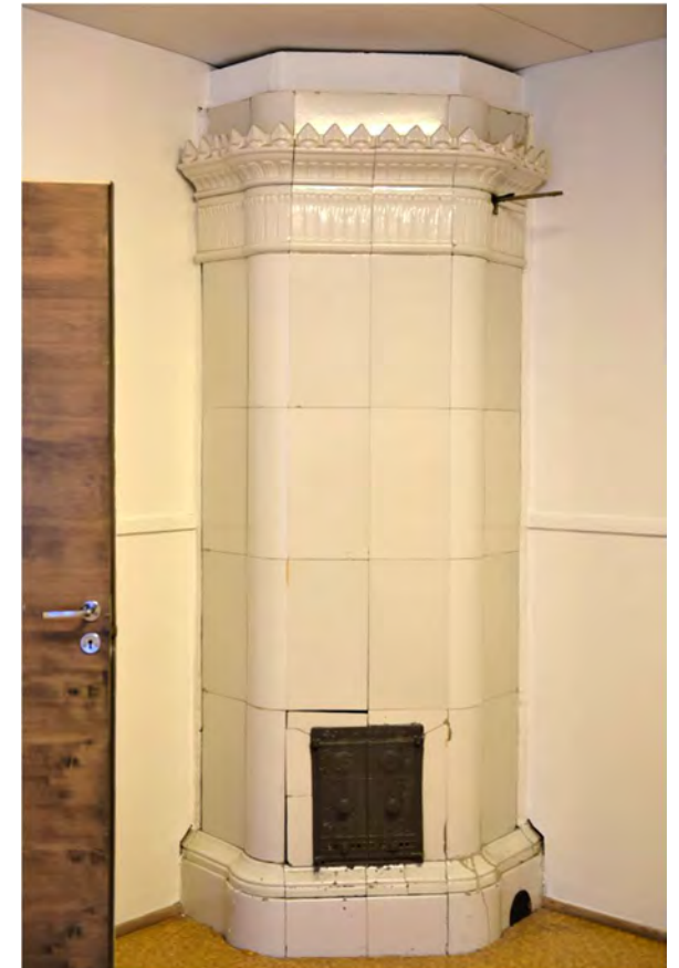
Kuva: Huone 23 eli asuntopäädyn keittiö, entinen peräkamari. Nurkkauuni, valkoinen, lasitettu, kruunu. Hormin savupiippu on purettu.
