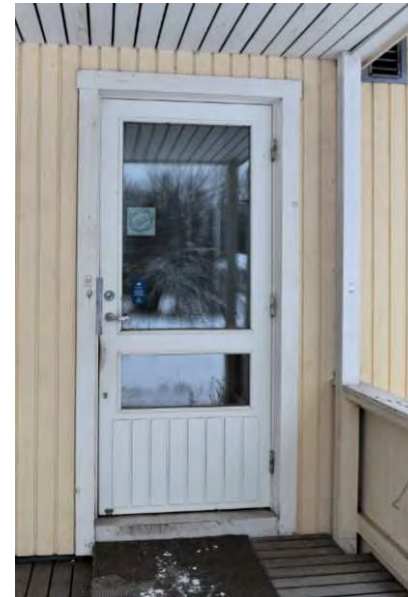
Kuva: Lasiukollinen pystypaneeliovi
